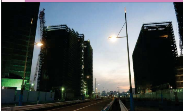
夜間点灯の様子（車道照明）
