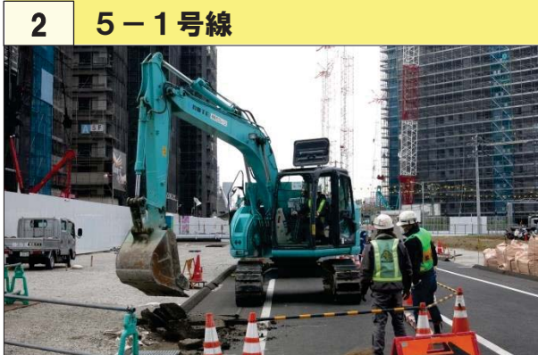
2 5-1号線 歩車道境に排水施設「街きよ」を設置するため、舗装を撤去しています。
