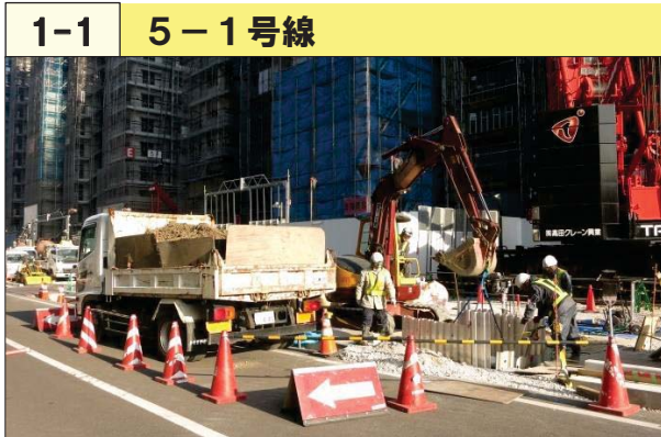
1-1 5-1号線 照明基礎を設置するため、歩道を掘削しています。
