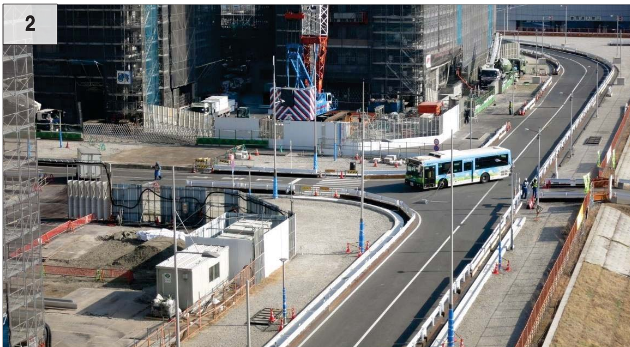
区画道路5-3号線と5-4号線のT字路（路線バスの通行）
