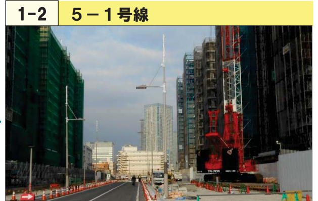
1-2 5-1号線 基礎を設置後、照明柱の設置を行いました。
